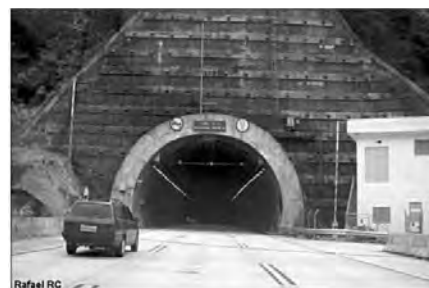
Figura 2: Sinalização na entrada do túnel
