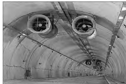
Figura 1: Sistema de ventilação longitudinal
