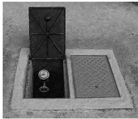
Figura 18: Registro de recalque para bombeiros
