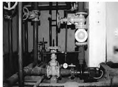
Figura 20: Bomba de incêndio e acessórios hidráulicos
